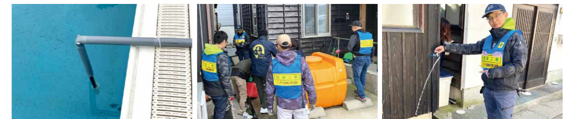
屋外プールの水を利用してトイレを復活 仮設給水タンクを設置 蛇口からやっと水が出た!(代表の田中友統さん)
